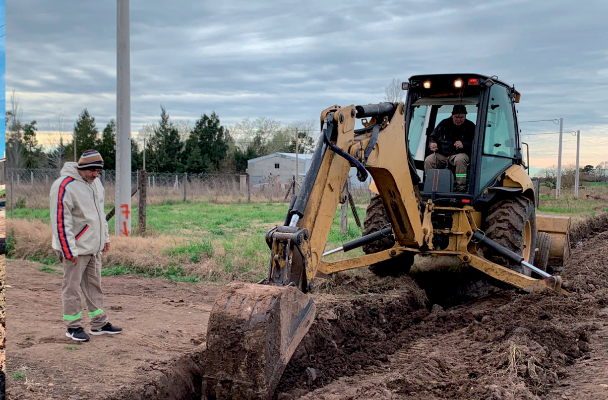
CORDÓN CUNETA, ECOPAV Y OBRA DE DESAGÜES PLUVIALES EN CALLE MÁRMOL DESDE SAN JUAN HASTA TUCUMÁN
